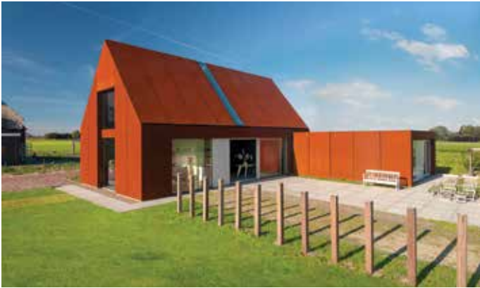
Geen doorvoer, rooster of buitenvoeler te zien: alles wat stoort is weggewerkt op het platte dak of achter de stalen bekleding.
