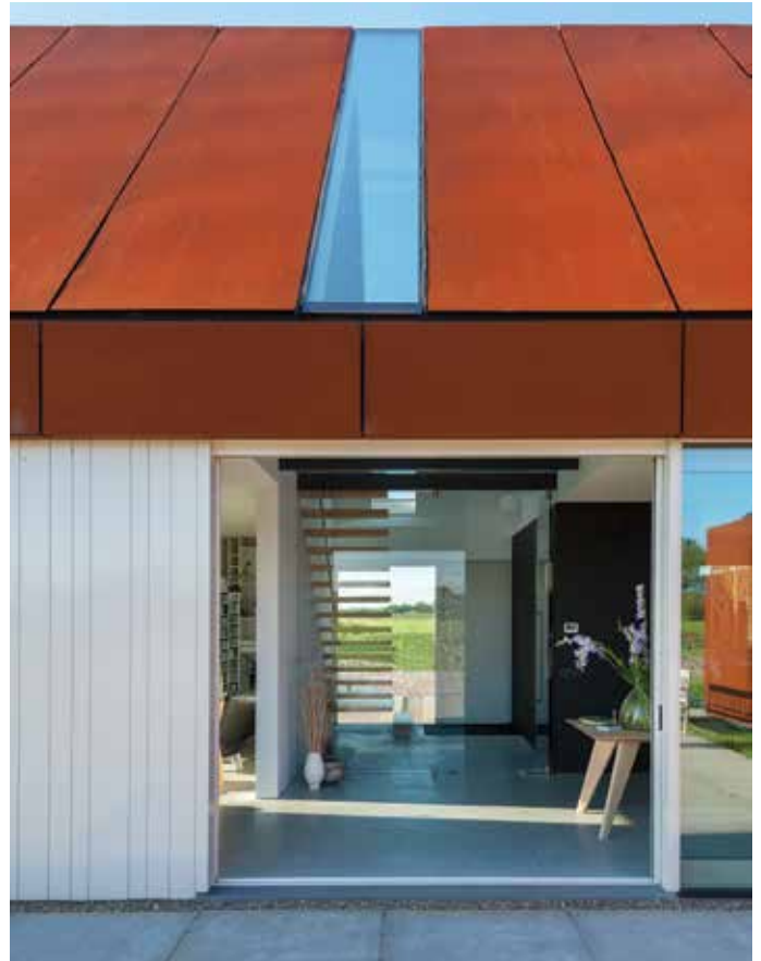
Het glas is gemonteerd met transparante folie. Het eerste jaar beschermt die de beglazing tegen aantasting door roest.
