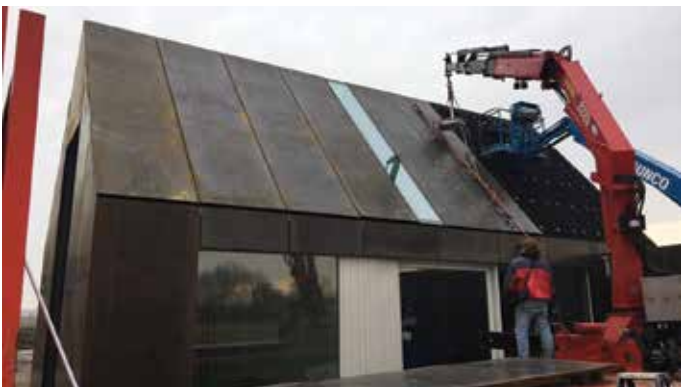
Standaard handelsmaten van de stalen bekleding bepalen de gevelopeningen. Zo komt de lichtstraat 'toevallig' uit in het midden van de entree.
